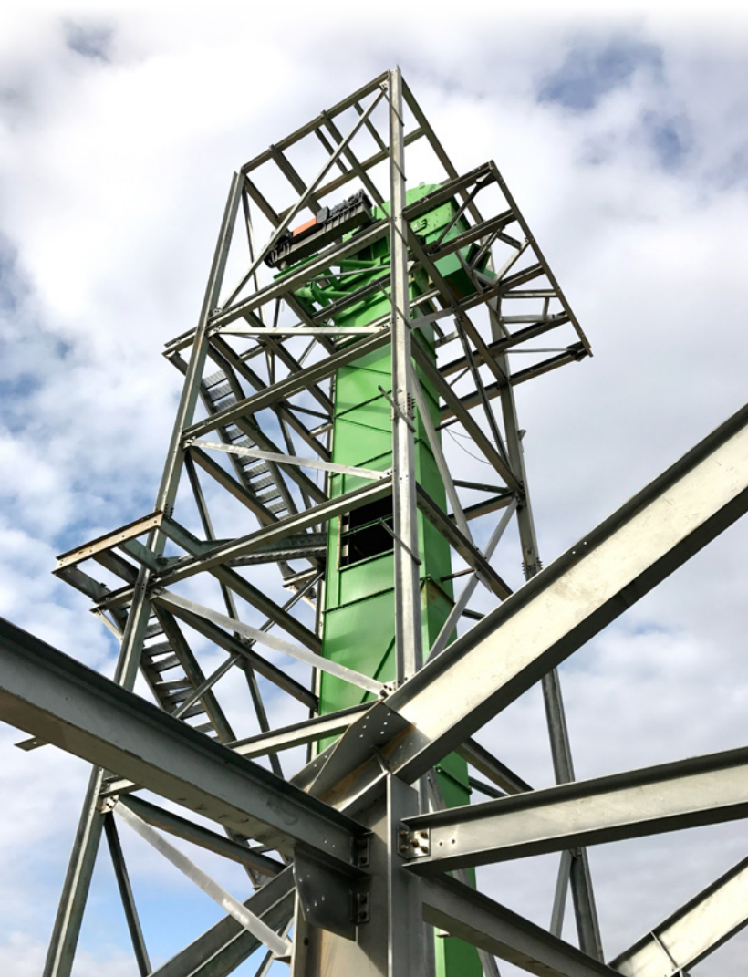
Porta de acesso para manutenção
