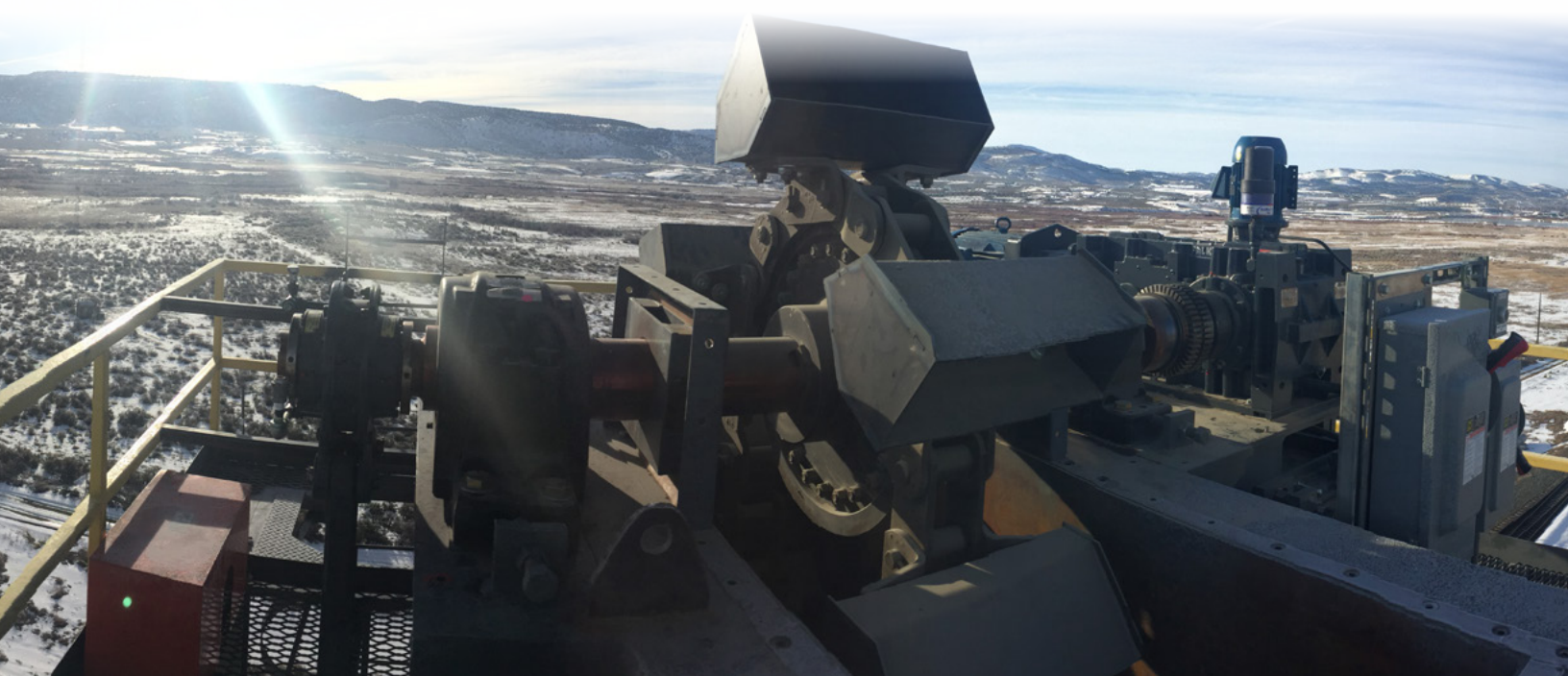
Roda de tração de anel segmentado na aplicação de cimento e agregados
